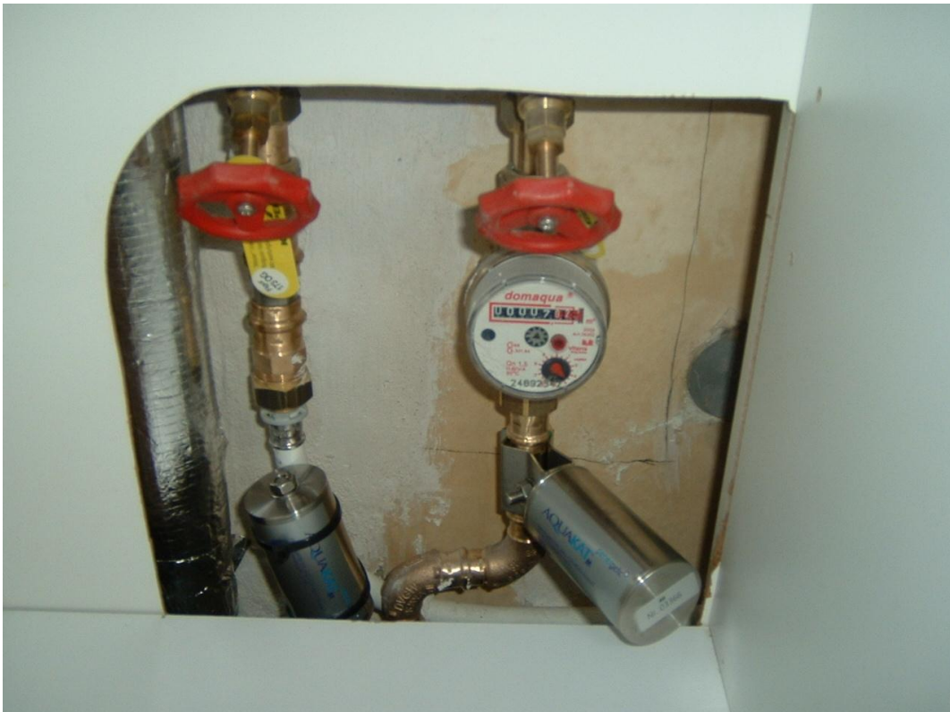
AquaKat-M für Kalt+Warmwasserverteilung i. d. Küche
