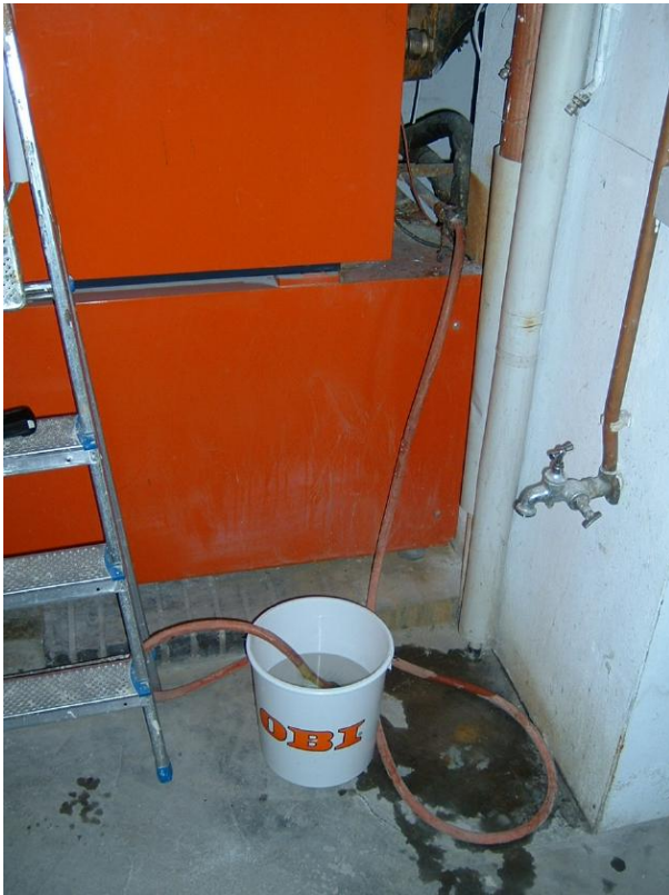
Entnahmeprobe vom Heizungswasser am 26.06.2008 (Bilder oben) Das Heizungswasser hat sich nach ca. 7 Wochen geklärt.
