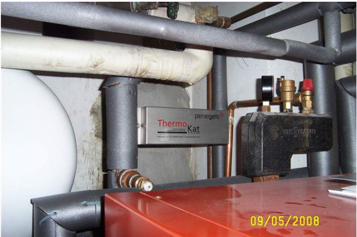
Montage eines ThermoKat am Heizungsvorlauf direkt hinter der Kesselanlage
