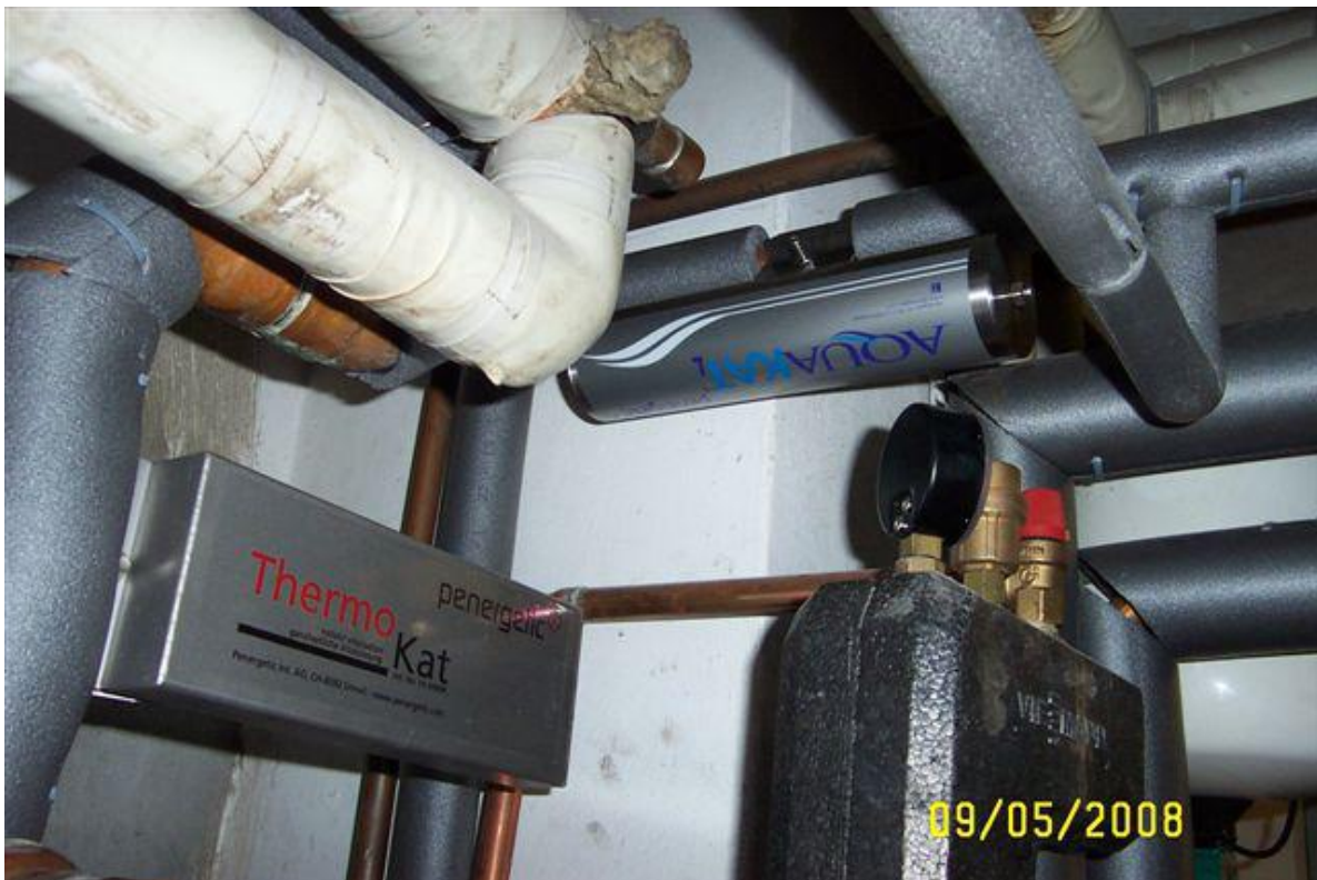
Montage eines AquaKat – L in der WW-Versorgungsleitung hinter dem Warmwasserbereiter zur Nachvitalisierung
