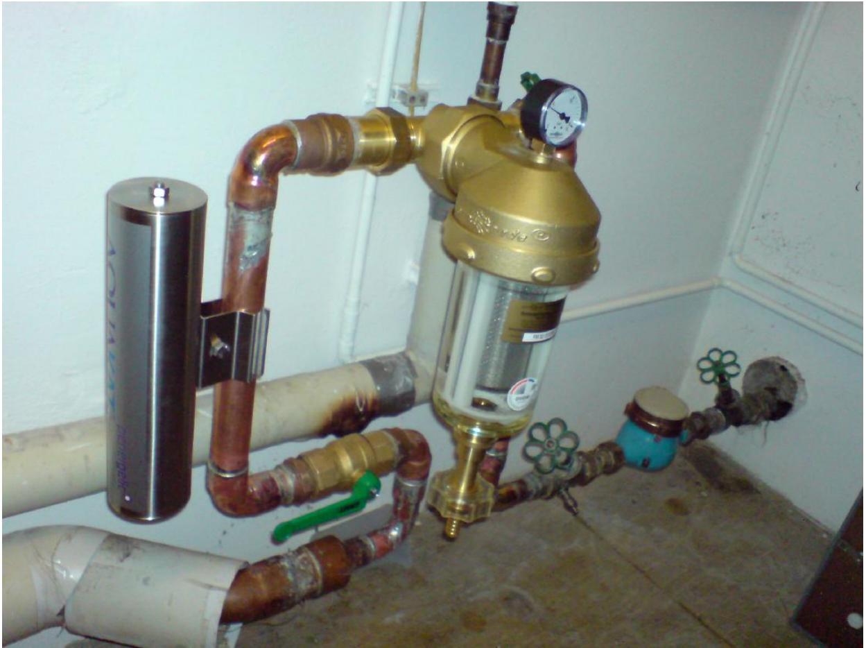
Montage eines AquaKat – L in der KW-Versorgungsleitung hinter der Rückspülfilteranlage
